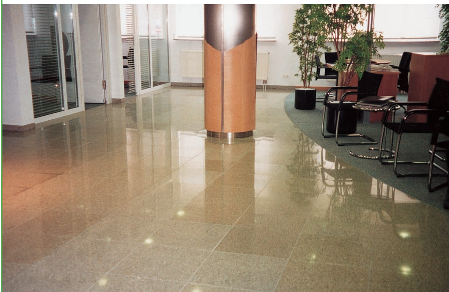
Chemisch nachbehandelter Granitboden in einer Schalterhalle
